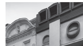
Přístavba Domu obuvi Zbrojnická 5
