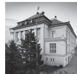
Správní budova Měšťanského pivovaru v Plzni U Prazdroje 7
